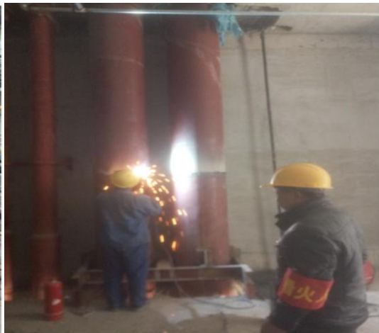
施焊作业配备灭火器、看火人
